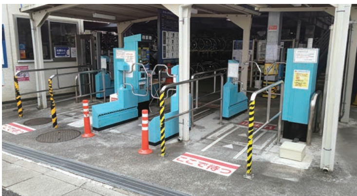
世田谷区様 新潟山南自転車等駐輪場
