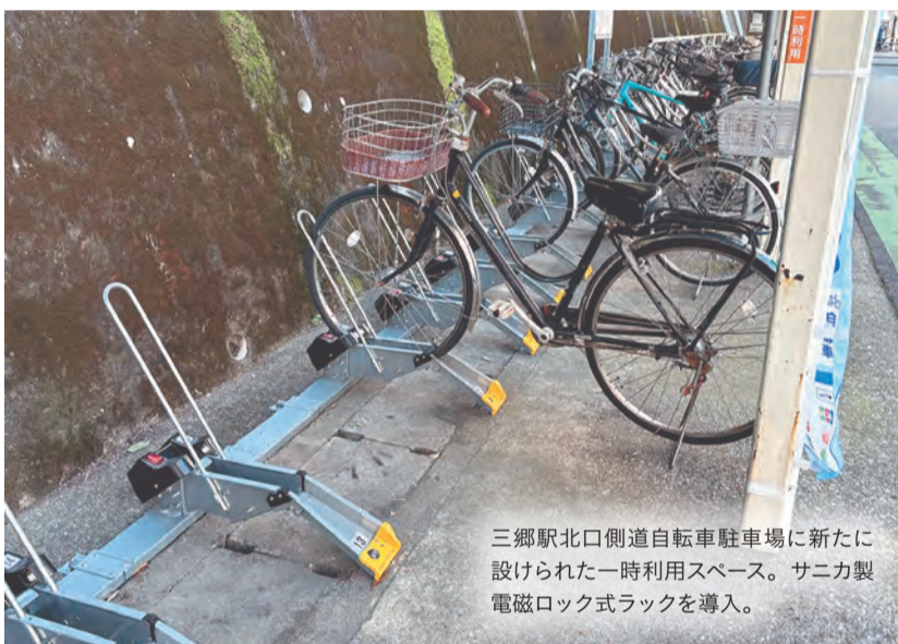
敷地内には精算機はなく、代わりに電磁ロックの制御・通信用ボックスを設置することで、「精算機のない自転車駐車場」として成立。
