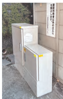
敷地内には精算機はなく、代わりに電磁ロックの制御・通信用ボックスを設置することで、「精算機のない自転車駐車場」として成立。
