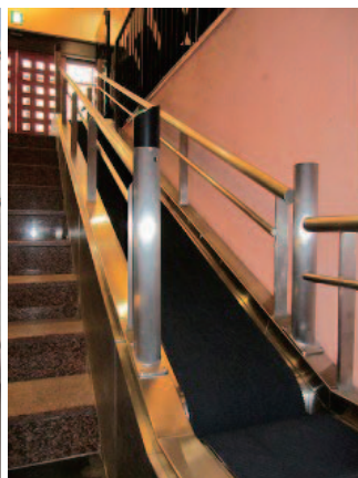
協栄バゲッジ・オートスロープ
