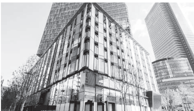
大名古屋ビルディング (4基952台) ビル組込み 地下円筒型
